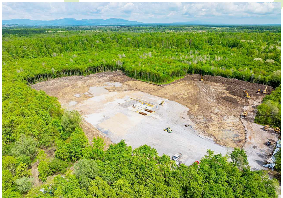
Uređenje radnog prostora na lokaciji buduće proizvodne bušotine geotermalne vode
